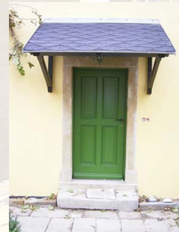
Haustür nach Originalvorlage mit Altbau- profilierung
